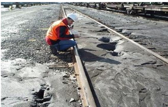
Gambar 3. Sand boiling akibat likuifaksi; (a) Mekanisme sand boiling, (b) Kondisi visual likuifaksi (Gempa Luzon 1990, Dagupan City)
