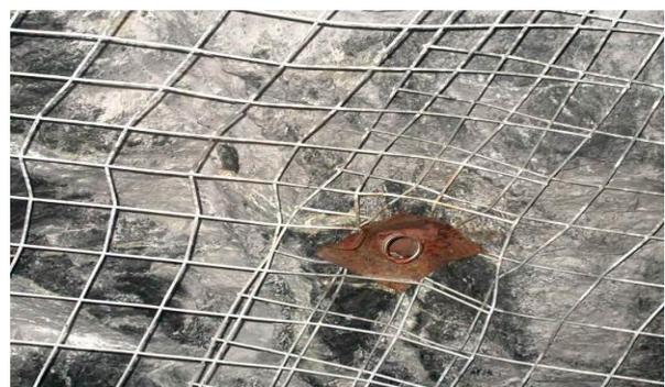
Gambar 4. *Weldmesh* atau *Wiremesh*
