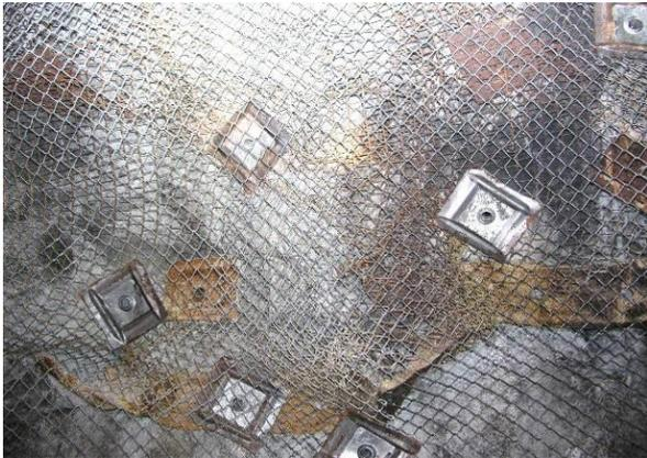
Gambar 5. *Wire mesh* atau *Chain link*
