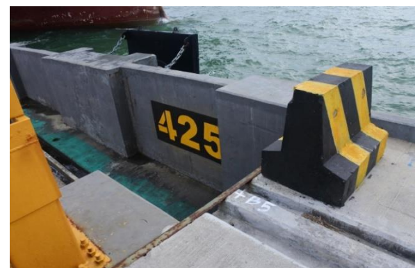
Gambar 2. Beda tinggi lantai dermaga atau jetty lama dan baru
