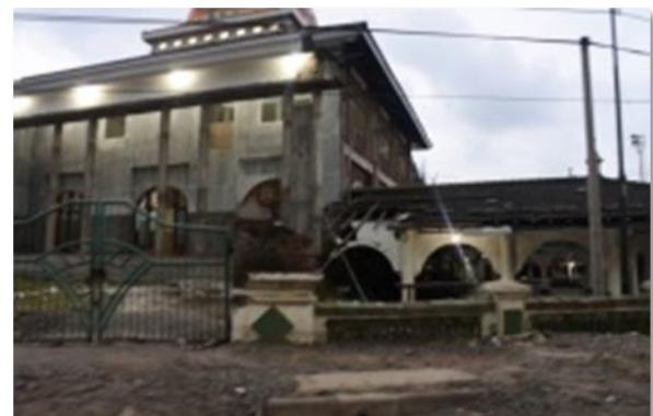
Gambar 3. Penurunan sebuah masjid (kanan) di areal pelabuhan Semarang
