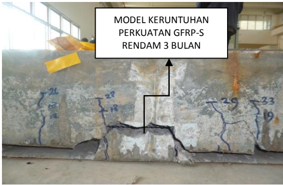
(d) Kegagalan tekan balok BF3
