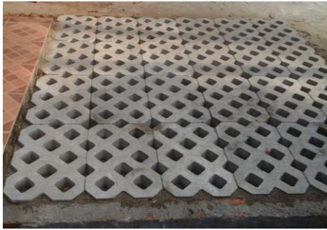
Gambar 6. Perkerasan halaman depan dengan grass block
