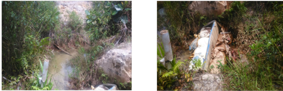
Gambar 3. Saluran menuju sungai Rimba Rakit dan Sekat Kanal (DAM)
