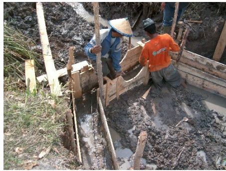
Gambar 2. Proses pegecoran untuk konstruksi gorong-gorong
