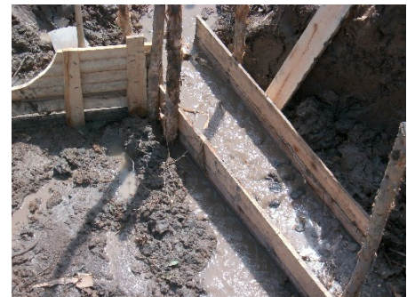
Gambar 2. Proses pegecoran untuk konstruksi gorong-gorong
