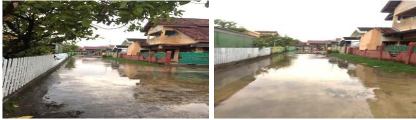
Gambar 6. Kondisi Banjir di Lorong Madura Kelurahan 2Ilir
