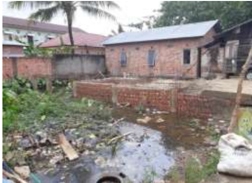
Gbr 2. Pompa Tidak Beroperasional di S Bendung, Palembang
