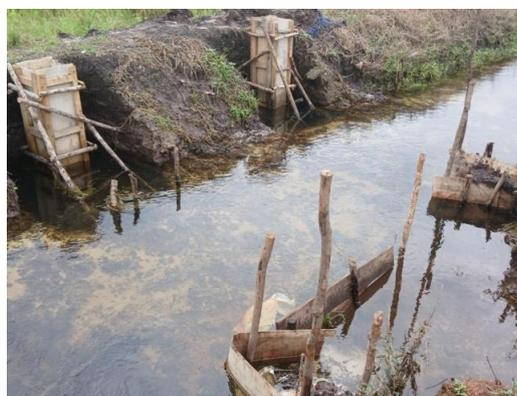
Gambar 9. Pekerjaan Jembatan Bentang 4 Meter Saluran Irigasi
