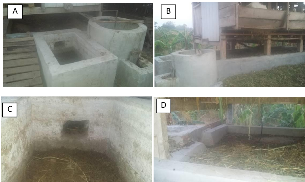
Gambar 3. Kandang kambing yang terintegrasi dengan instalasi biogas, (A, B). Bak penampungan dan bak perendaman, (C) Lubang penghubung antara lantai kandang dan bak penampungan (D). Lantai bawah kandang kambing
