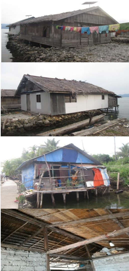
Gambar 3. Kondisi rumah nelayan di Kabupaten Morowali
