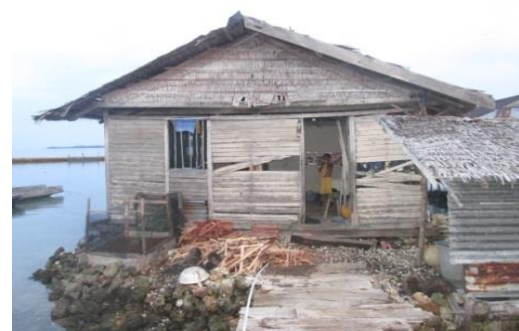
Gambar 2. Kondisi rumah nelayan di Kabupaten Morowali
